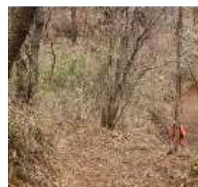
補修した上杉進入路
