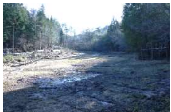
工事の様子、工事後の風景
