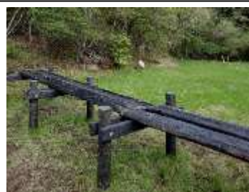
擬木杭を使用した木道延長部分
