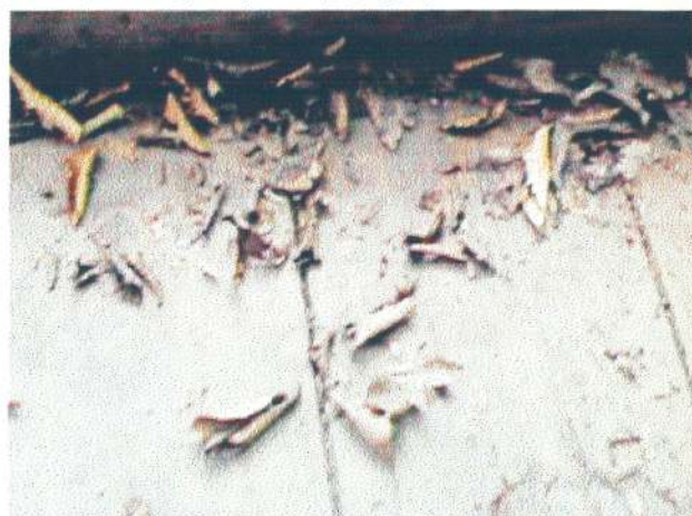
東デッキ (林道側)
