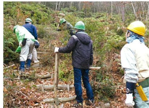
NTT ドコモ堀河の森作業路整備(H29)
